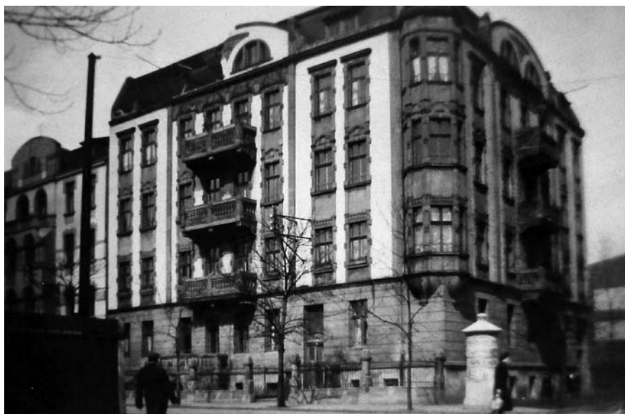
Kamienica Roberta Pietruszki przy ul. Śmiłowskiego 5 przed przebudową
