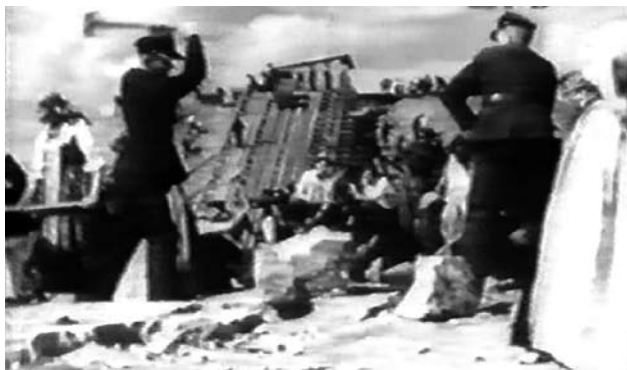
Budowa Kopca Wyzolenia w Piekarach Śląskich
