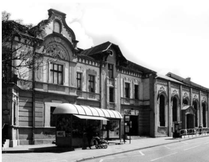
Dawny budynek gospody, obecnie siedziba Siemianowickiego Centrum Kultury
