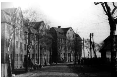
Budynki mieszkalne dla robotników z kolonii Sadowki
