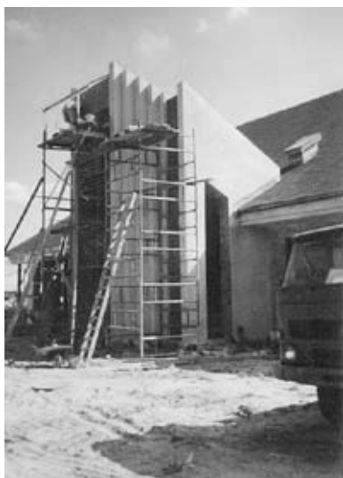
Budowa ośrodka Caritas w Rusinowicach
