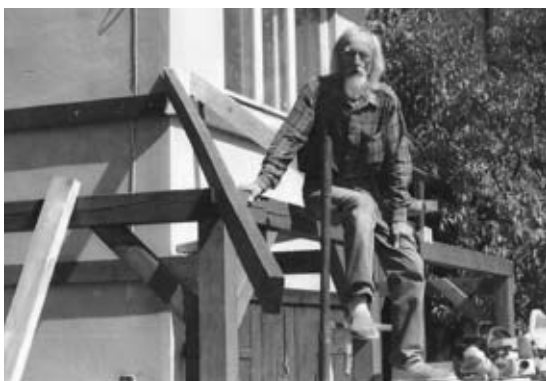
Na budowie domu w Wymysłowie
