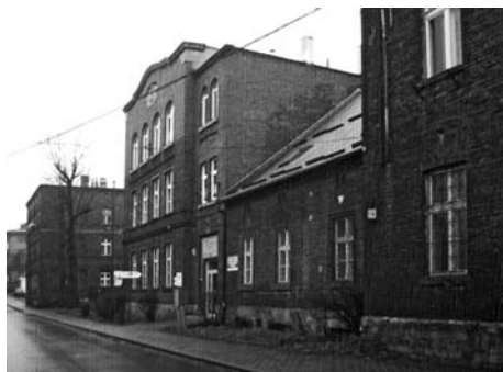
Budynek szkoły przy ulicy Pszczelniczej 10
