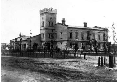
Cechownia i budynek administracji kopalni Siemianowice, fot. z ok. 1860-70, ze zb. Muzeum w Chorzowie
