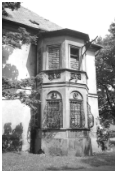
Wykusz w skrzydle południowym - dawna biblioteka
