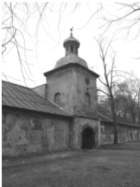
Brama wjazdowa z dzwonnica (fot. z 2004 r.)
