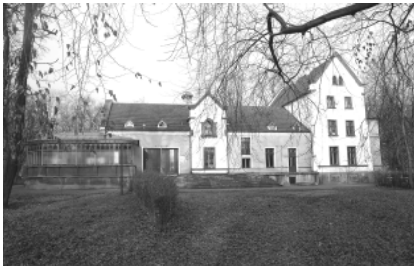
Zameczek michałkowicki. Elewacja ogrodowa - fasada południowa (fot. z 2004 r.)
