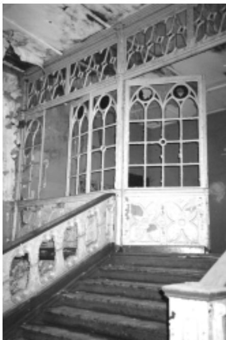
Neogotycka klatka schodowa w skrzydle zachodnim
