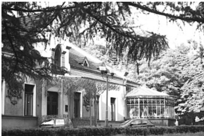
Pałac Rheibabenów, elewacja frontowa
