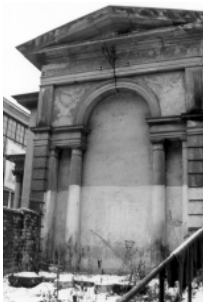
Wyjście z sali balowej do ogrodu; stan z 2000 r.
