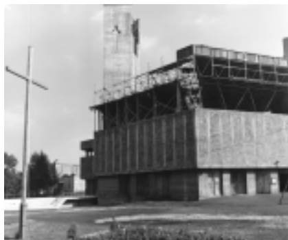
Plac budowy kościoła
