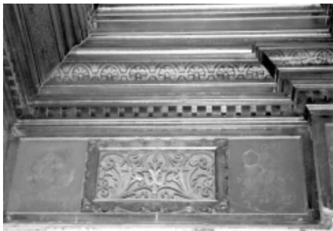
Fragment stropu kasetonowego i malowideł w sali balowej
