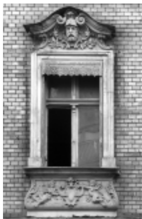
Okno z ozdobnym naczółkiem i kartuszem z puttami - kamienica przy ul. Krótkiej 7.
