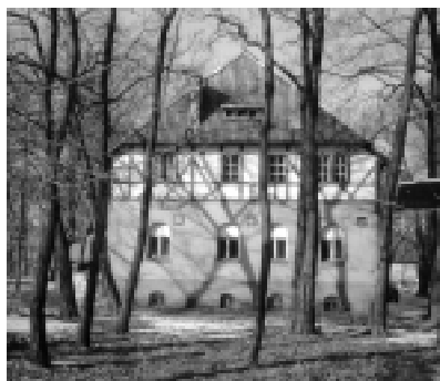
Budynek byłej kuchni szpitalnej z 1908 r.
