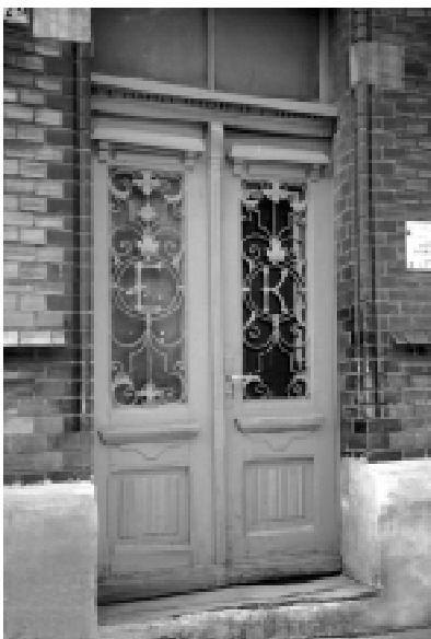
Brama wejściowa do kamienicy przy ul. Kościelnej 17 - stan z r. 1996.
