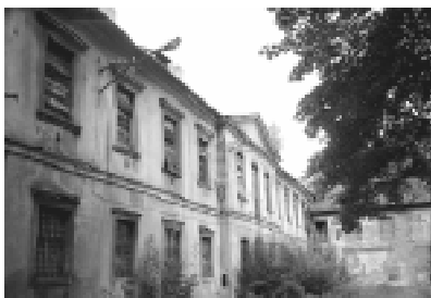
Zachodnie skrzydło pałacu - stan z 2002 r.
