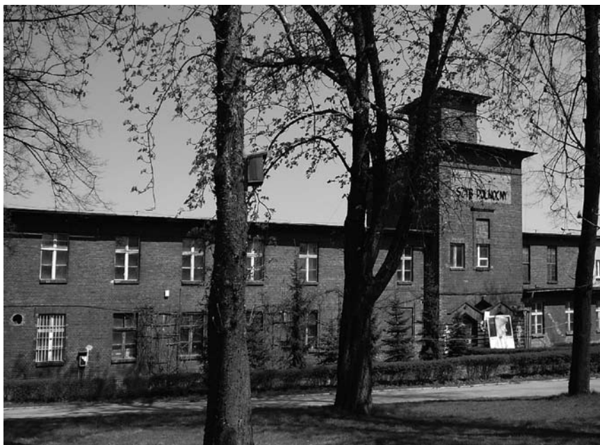
Kompleks łazienno-biurowy - Szyb Północny kopalni „Siemianowice”
