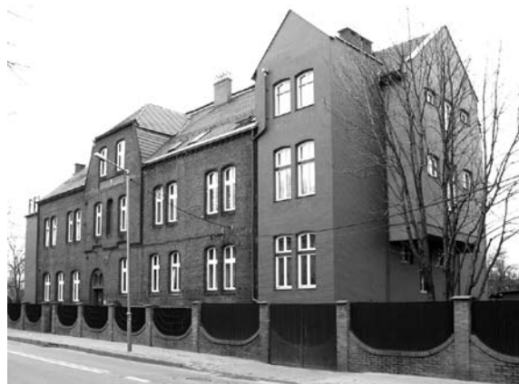
Dom michalkowicki po rozbudowie części wschodniej w 2001 r.
