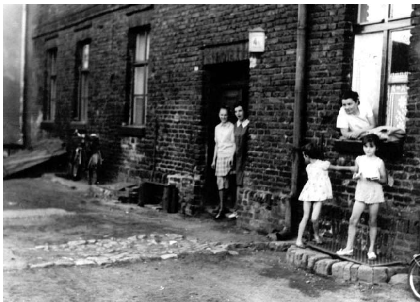
Budynek na Srokowcu – latem (fot. A. Bratek)
